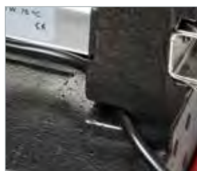
Kabelführung cable channel
